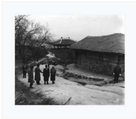
대한민국 정부기록 사진집 4 - 도로 포장 공사 현장 시찰 중인 이승만 대통령 #822
